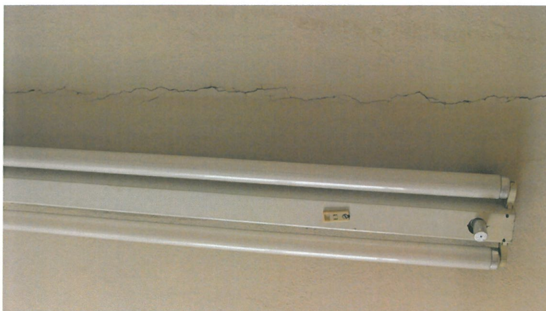
Fot.8. Sufit korytarza
